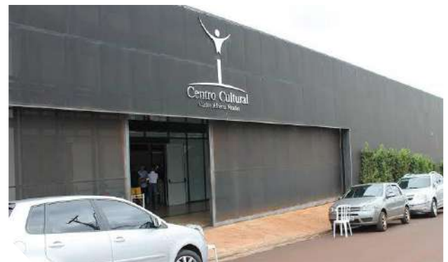
Fachada do Centro Cultural Carlos Alberto Nicolau
